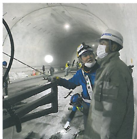
北沢トンネル舗装工事
