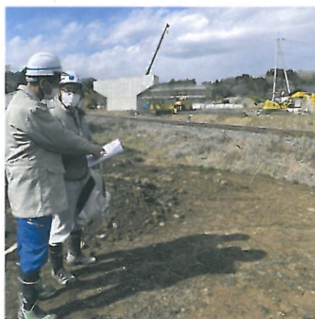
袋田バイパスJR跨線橋
