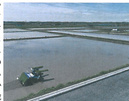
常陸太田市小目地区の基盤整備事業
