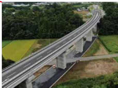
開通した長尾橋(第 3 号橋)
