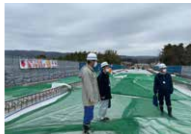
工事中の第 3 号橋(長尾橋)視察
