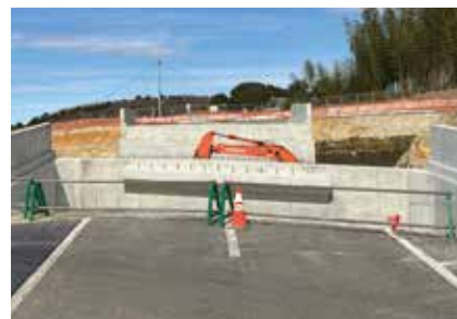
菅田小学校南側のバイパスと市道との立体交差点部
