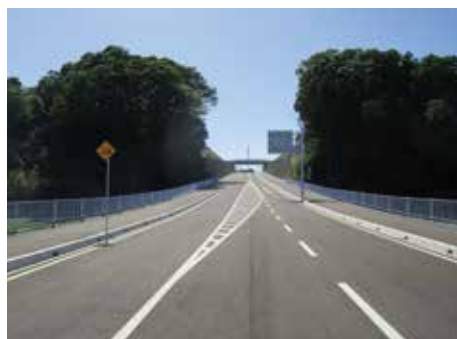
349 号線からの入口
