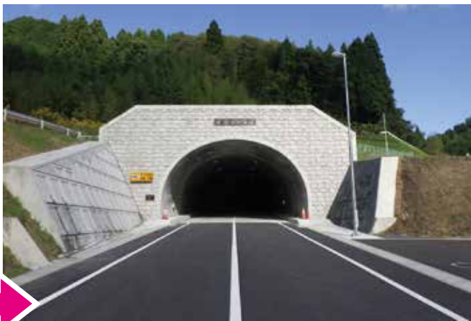
開通した北沢トンネル
