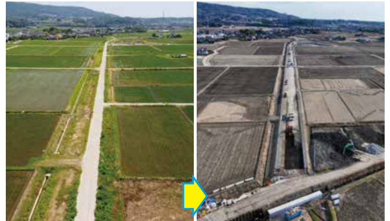
真ん中の幹線道路が完成に近づいています。
