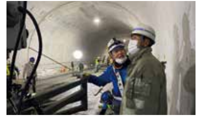
北沢トンネル工事視察
