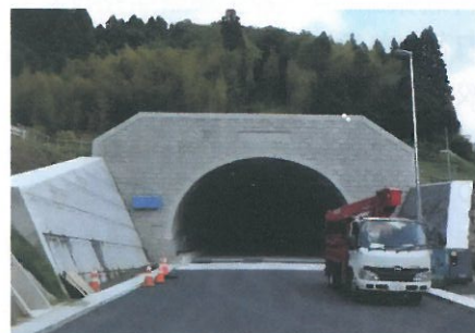
下高倉側北沢トンネル
